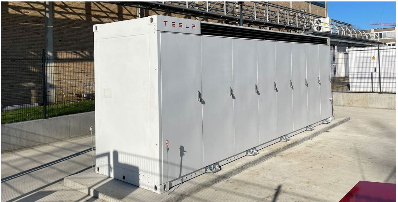
Abb. 5: Hochenergie-Batteriesystem (Tesla-Megapack) auf dem Campus des FZJ (Quelle FZJ)
