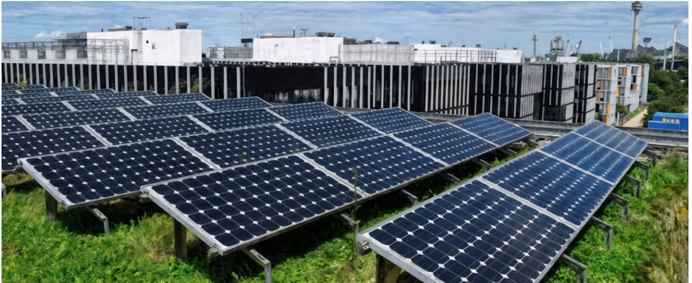
Abb. 6: Beispiel für ein Solargründach, bei dem die Begrünung unter den PV-Modulen verläuft. Quelle BuGG
